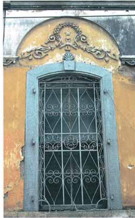
Resim 4 - Taş Söveli, Giyotin Doğramalı Demir Parmaklıklı Pencere Tipi
