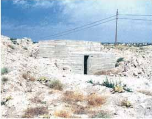
res. 1: Gökçe Kısık Frig Yerleşmesi. Su deposu.
