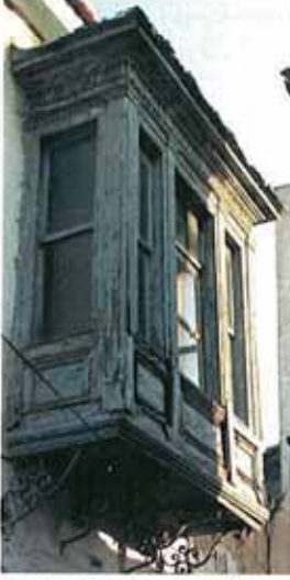
Resim 1 - Dövme Demir Konsollu Ahşap Cumba Örneği
