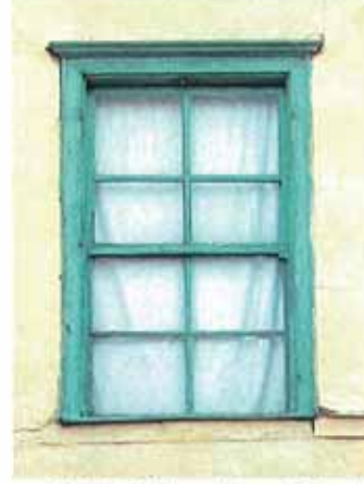
Resim 2 - Ahşap Pervazlı Giyotin Doğramalı Pencere Tipi
