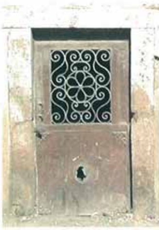
Resim 3 - Metal, Tek Kanatlı Kapı Tipi (Bodrum Kapısı)
