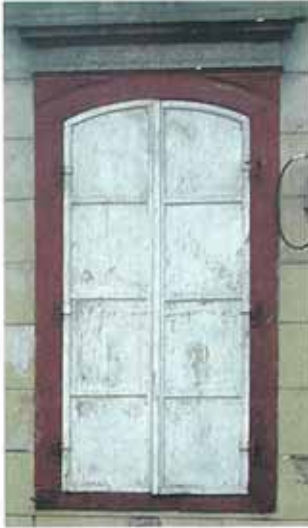
Resim 3 - Taş Söveli, Demir Kepenkli Pencere Tipi
