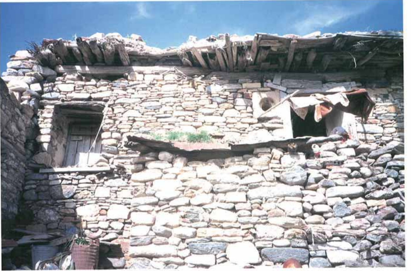
res. 1: Attouda, ev duvarında taşa oyulmuş boru.
