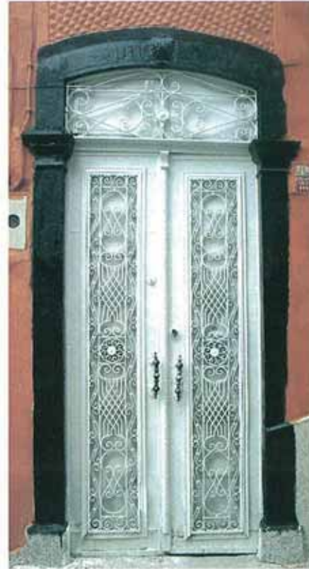
Resim 4 - Metal Çift Kanatlı, Kemerli, Üstü Havalandırılmalı Kapı Tipi (Yere Kadar Parmaklıklılı)
