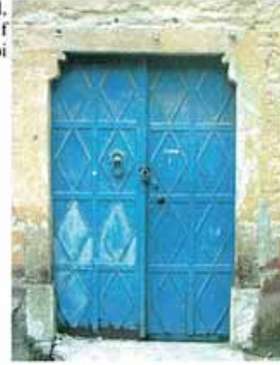
Resim 2 - Metal, Çift Kanatlı, Masif Kapı Tipi
