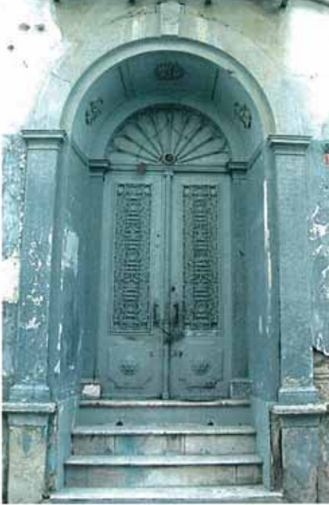
Resim 1 - Metal Çift Kanatlı, Kemerli, Üstü Havalandırılmalı Kapı Tipi (Altı Masif, Üstü Parmaklıklılı)
